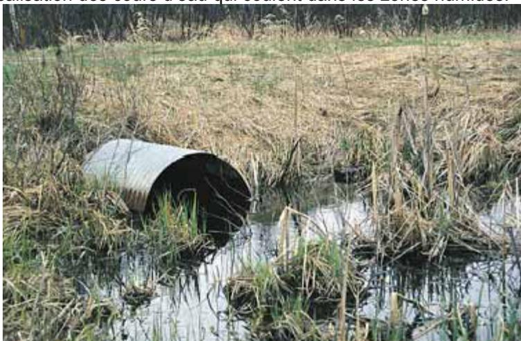
**Les ponceaux des zones humides permettent le drainage transversal si le remblai de la route ne suffit pas.**
