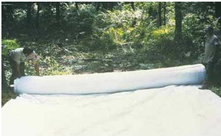
**Utiliser un géotextile pour éviter que le remblai ne se mélange au sol humide.**
