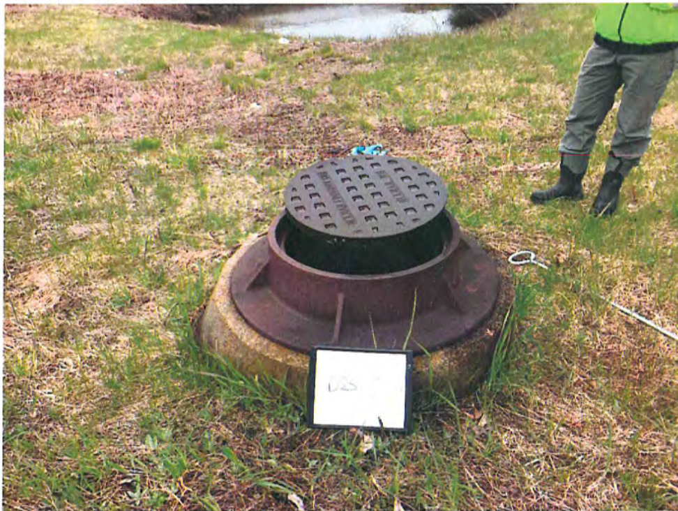
D2S #2A Exterior
